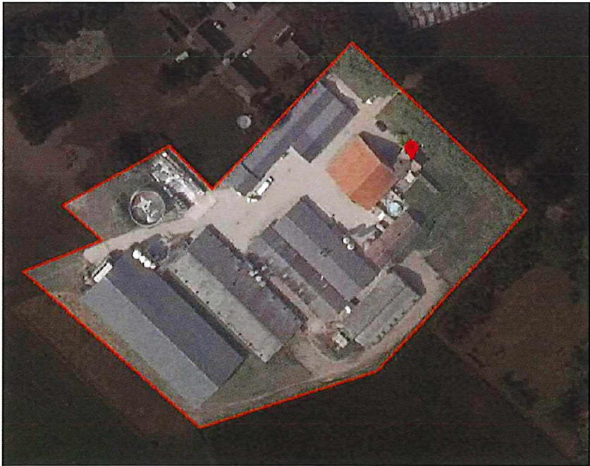
Luchtfoto 'oude' situatie voor sloop voormalige stallen
