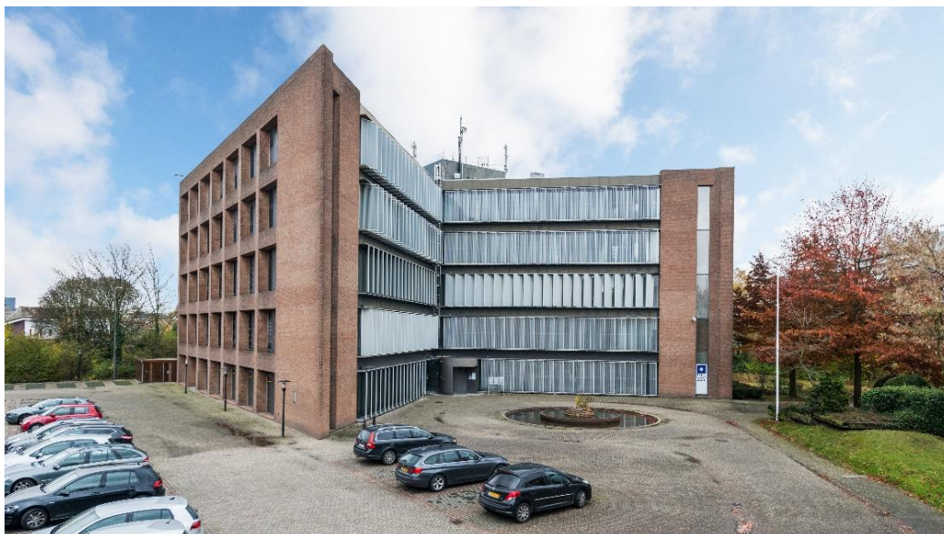
Afbeelding 2. Indruk van de noordwest- en zuidwestgevel van het kantoorpand in het plangebied (foto's: NSI, 2017).
