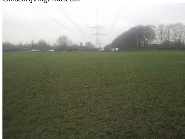
Fotonummer: 6 Omschrijving: Mast 30.
