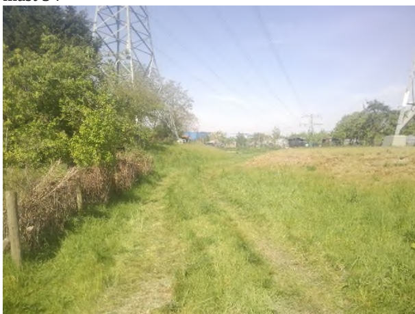
Fotonummer: 9 Omschrijving: Noordelijk van TenneT station, nabij mast 34
