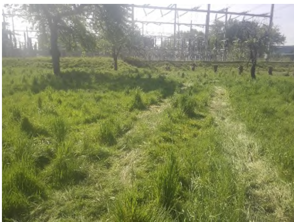
Fotonummer: 7 Omschrijving: Noordelijk van TenneT station, nabij mast 34
