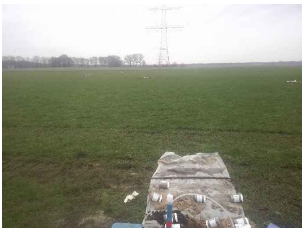
Fotonummer: 1 Omschrijving: Mast 30.
