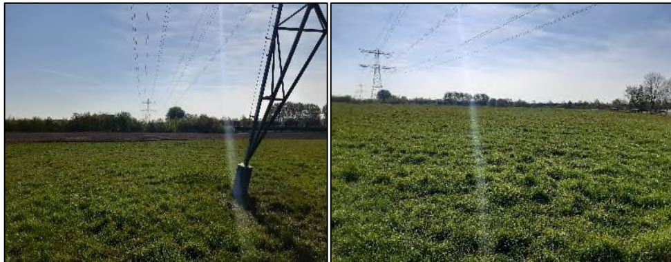
Figuur 4.2. Tracé Breda – Roosendaal: impressie ter plaatse van mast 49.
