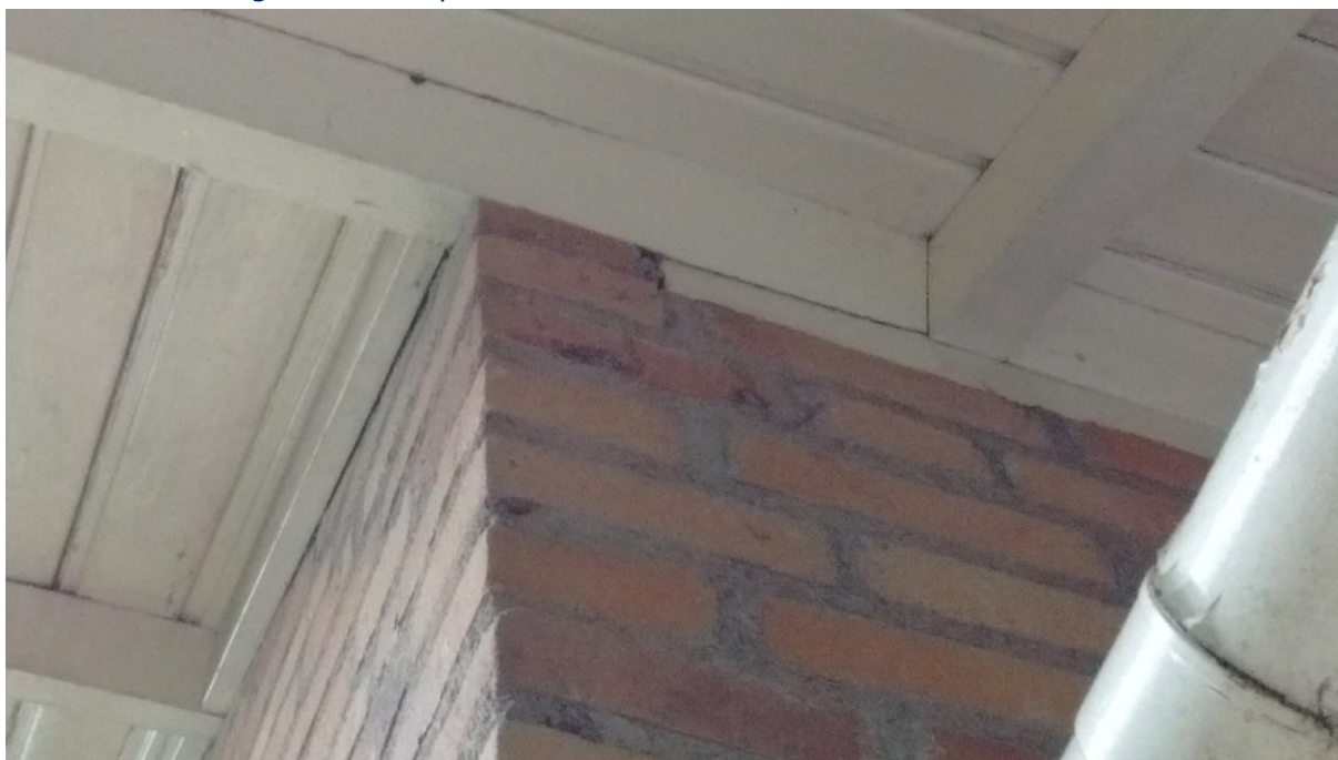
Dichte aansluiting van hout op metselwerk woonhuis:
