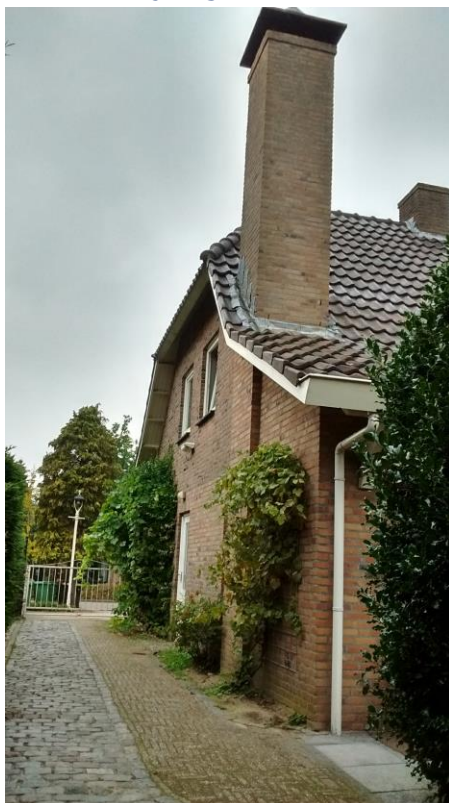
Zuidwestelijke gevel van de woning:
