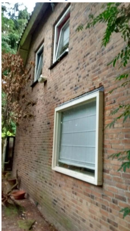
Noordoostelijke gevel van de woning:
