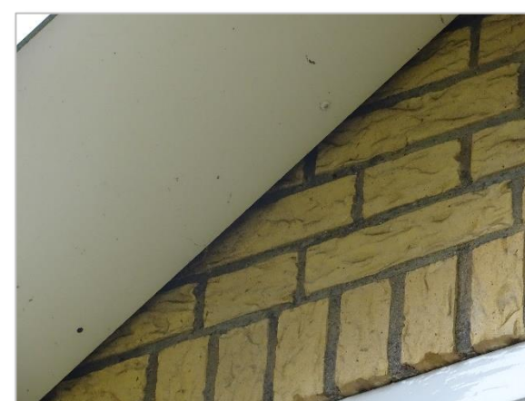
Foto 12: Impressie woning Roosbergseweg 6 te Bavel (woning kopse kant dak).
