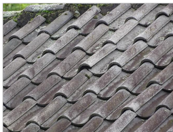
Foto 18: Impressie werkschuur Roosbergseweg 6 te Bavel (dakbedekking).
