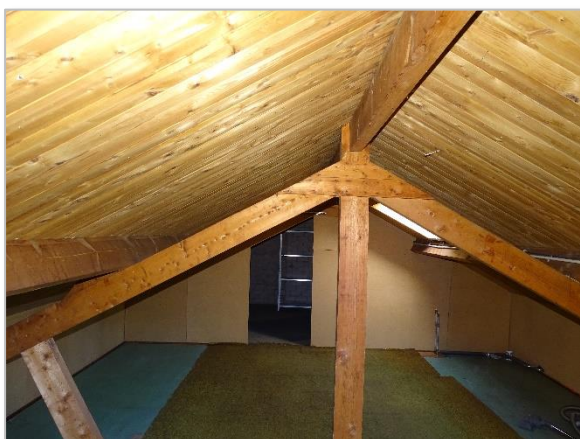
Foto 13: Impressie woning Roosbergseweg 6 te Bavel (zolderruimte).
