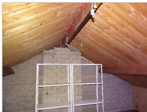
Foto 14: Impressie woning Roosbergseweg 6 te Bavel (zolderruimte).
