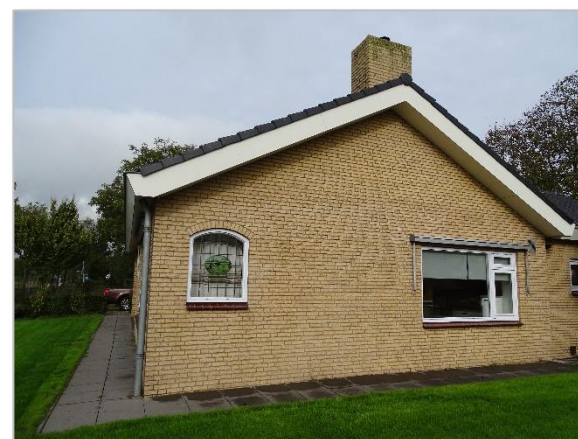
Foto 10: Impressie woning Roosbergseweg 6 te Bavel (woning/kopse kant dak).
