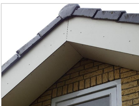
Foto 11: Impressie woning Roosbergseweg 6 te Bavel (woning/kopse kant dak).
