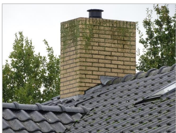
Foto 9: Impressie woning Roosbergseweg 6 te Bavel (dak woning).
