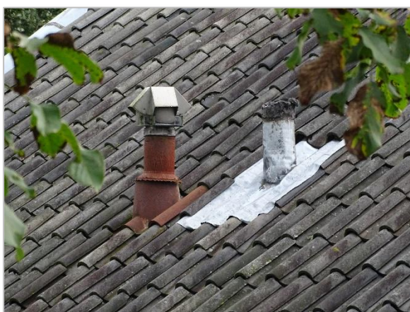
Foto 17: Impressie werkschuur Roosbergseweg 6 te Bavel (dakbedekking).
