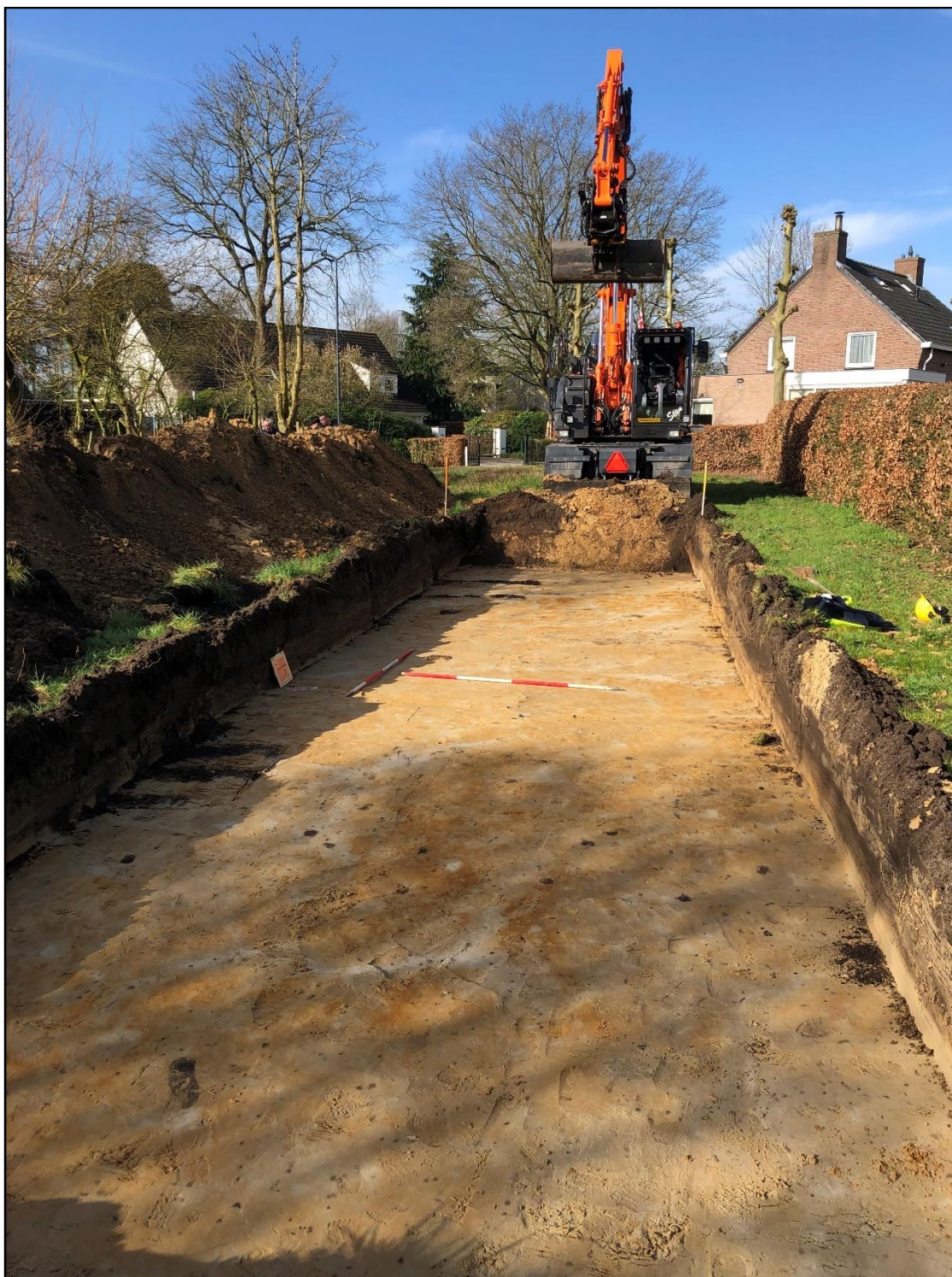
Figuur 7. Overzichtsfoto van vlak 1 in werkput 2, waarin geen archeologische sporen werden aangetroffen.
