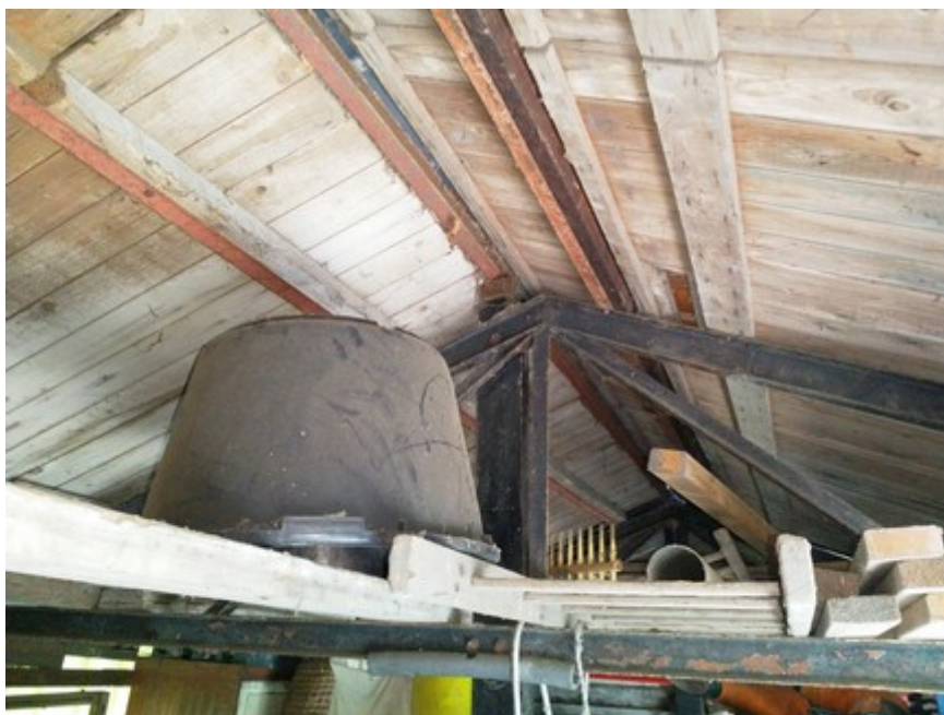
Het dakvlak aan de binnenzijde van opstal 2. De ruimte tussen dakpan en dit dakvlak is geïnspecteerd. Foto: V. Stuit | Ecoresult B.V.
