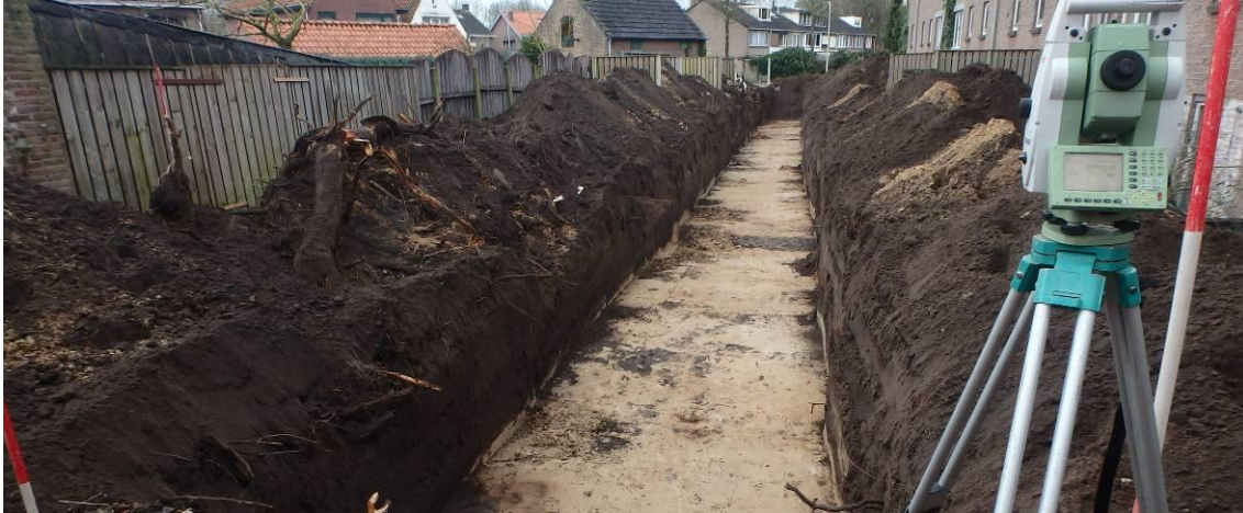
De beperkte ruimte bij de aanleg van put 3.
