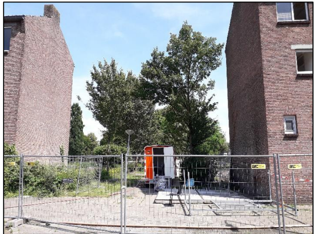
Figuur 4 géén boom beschermende maatregelen tijdens de sloop
