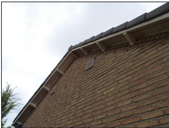
Figuur 10. Dak met ruimtes onder dakpannen toegankelijk voor vleermuizen.
