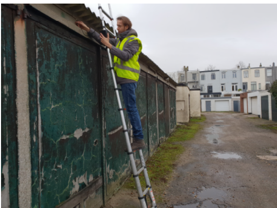
Figuur 1: Uitvoering endoscopisch onderzoek aan de garageboxen.
