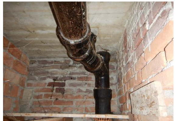
Gietijzer riool met loden afdichting
