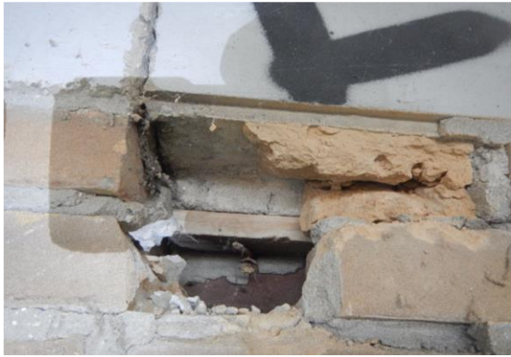
Spouwdichtlegging van hout
