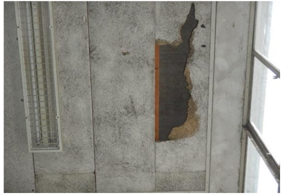
Houtwol cement plafonds
