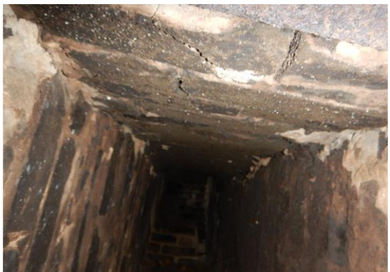
Gemetseld schoorsteen kanaal
