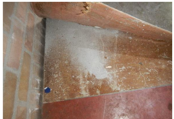
Linoleum op schone betonvloer
