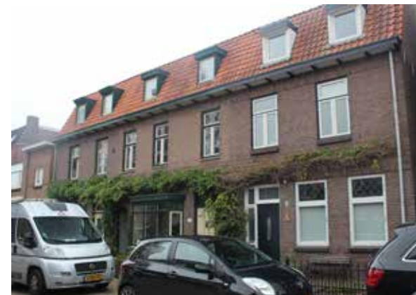
doorlopende dakrand en begroeiing
