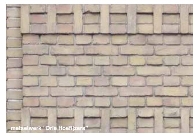
verschillende materialen in zelfde kleurtoon, plint met tegels reageert op hoogteverschillen/andere elementen
