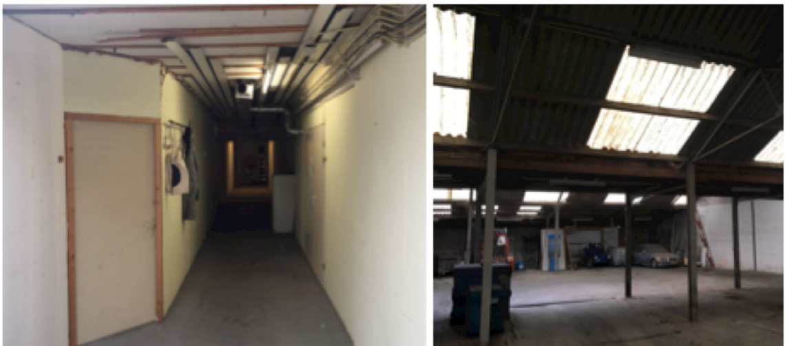
2. Binnen in het complex.
