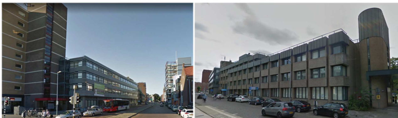
Figuur 5: Bestaande situatie aan de Markendaalseweg ter plaatse van de nieuwbouw (links vanuit het zuiden; rechts vanuit het noorden). (Google Maps, augustus 2017; datum van de opname(n) is onbekend.)
