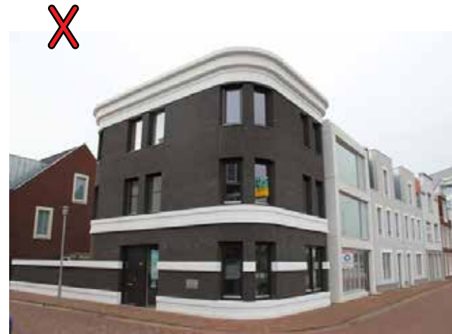
NIET: overdadige ornamentiek dakrand
