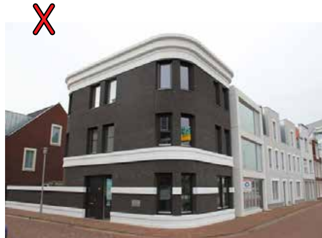
NIET: overdadige ornamentiek dakrand
