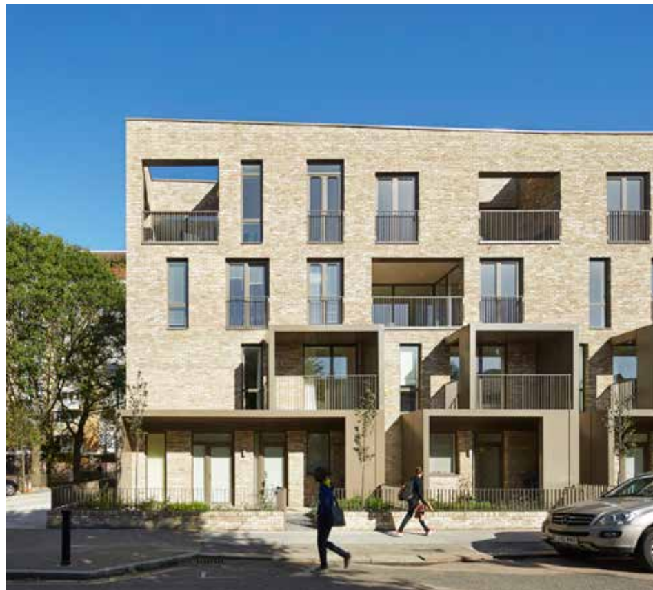
WEL: dakrand verhoogd en scherp gesneden
