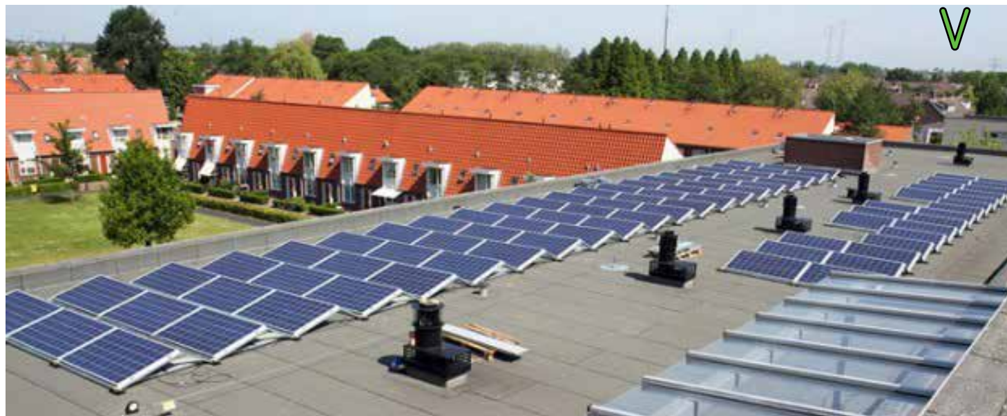
dakvlak gebouw A1
