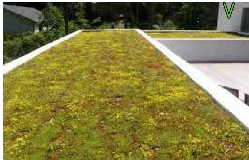
WEL: zichtgroen dakafwerking op dak toplaag
