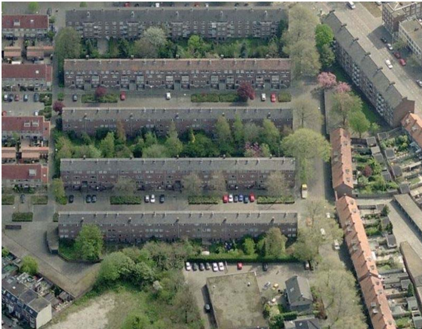
Figuur 7. Situatie voor de sloop van de woonblokken. Bron: Bing Maps
