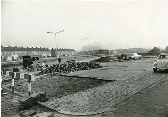
Figuur 2.4 Aanleg van de Doornboslaan
