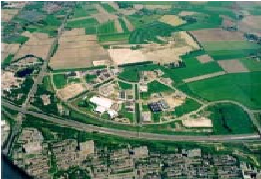
Bedrijventerrein Hoogeind in aanbouw
