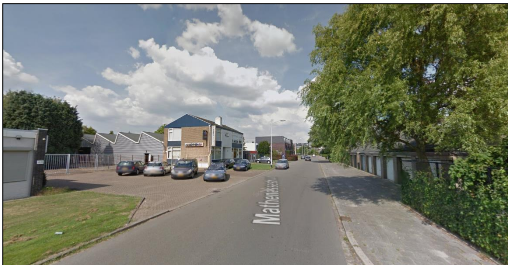
Foto van de Mathenessestraat in noordoostelijke richting, gezien vanaf het plangebied.
