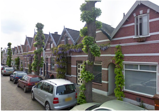
Figuur 5 Woningen aan de Ploegstraat
