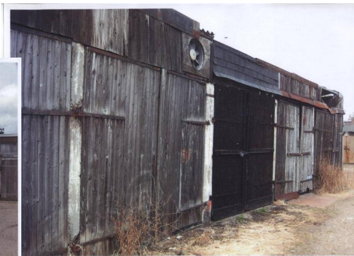
Te slopen bestaande garage boxen
