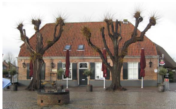
Langgevelboerderij aan Raadhuisplein (rijksmonument)
