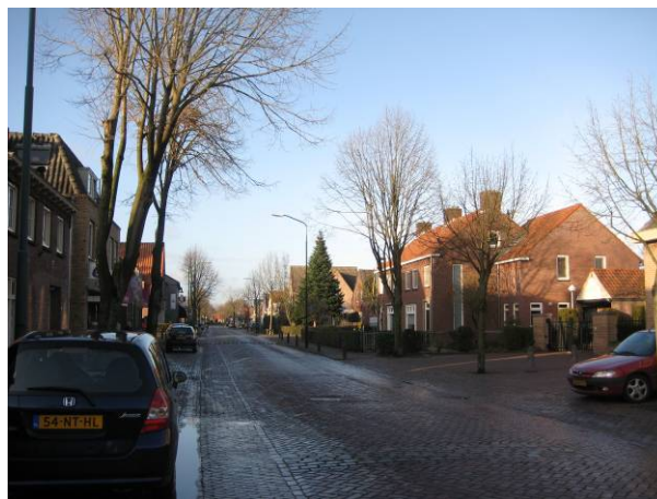
Eenvoudig straatprofiel met gebakken klinkers (Nieuwstraat)
