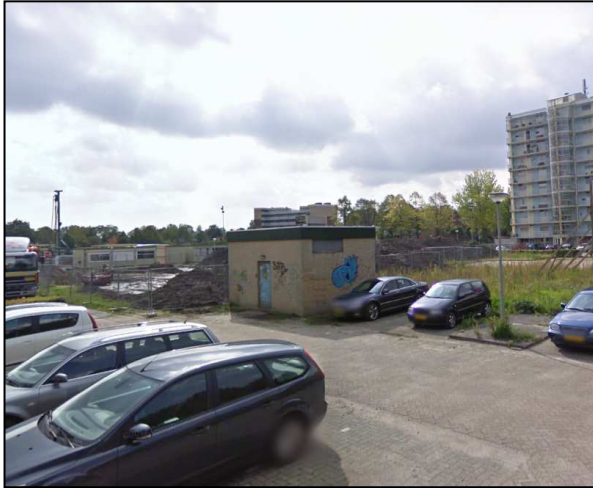
Figuur 5: Bestaand VodafoneZiggo-station binnen het plangebied (Bron: Google Streetview)
