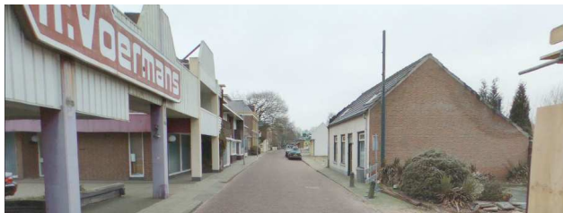
Steenstraat, oude situatie: voor de sloop van de panden aan de westzijde van de straat
