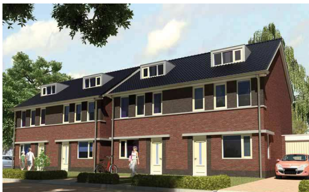
Geen kapverdraaiing, Hoge goot, plint, gevelverspringing, geveldetail, eigentijds
