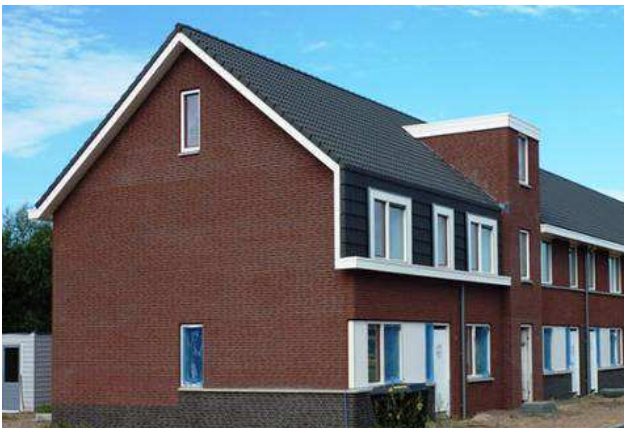
Combinatie hoge goot en lage goot, eigentijds gebruik van de kapvorm, strakkere vormgeving gevelopeningen, plint, maar verticaal plat gedekt tussenelement ongewenst
