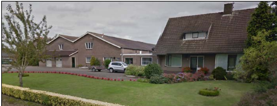
Figuur 4: Foto bestaande situatie
