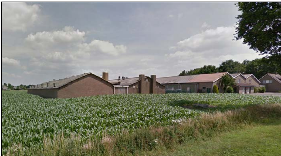
Figuur 5: Foto bestaande situatie
