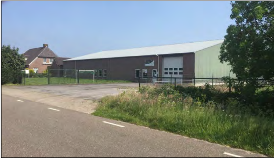
Figuur 50: Foto van het bedrijf aan Waterdelweg 2b
