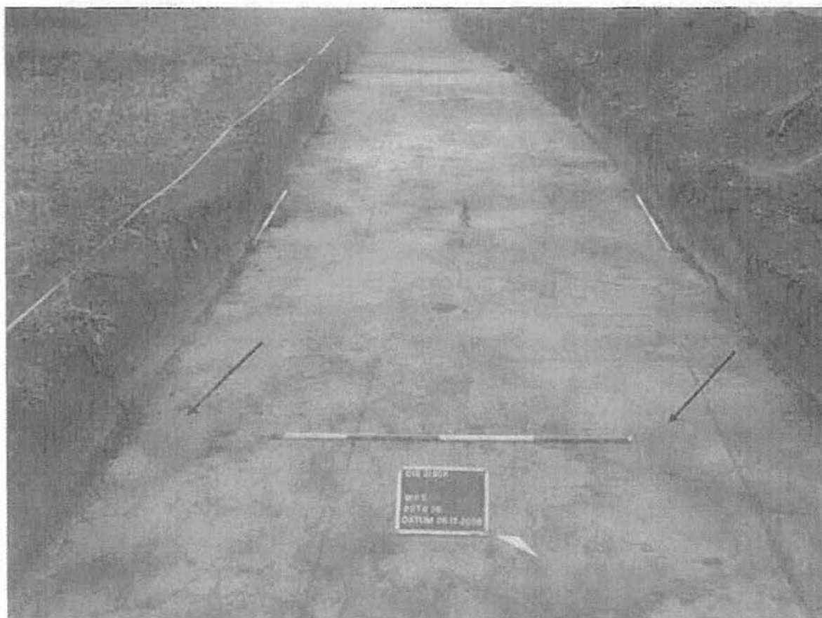
Figuur 5: Roestvlekken (de oranje verkleuringen, zoals aangegeven door de rode pijl, in werkput 5.
