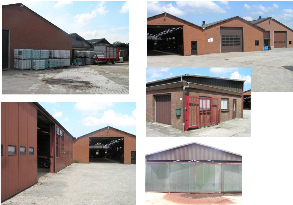
Figuur 5: loodsen loonwerkersbedrijf in zuidwesten planlocatie (nr. 3 op luchtfoto figuur 2).
