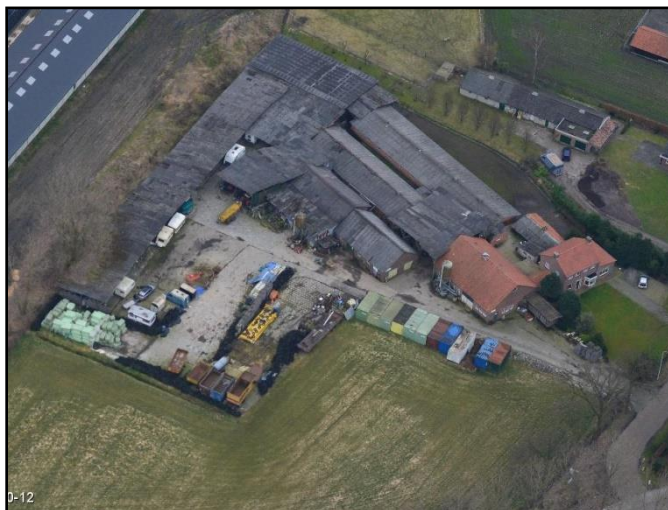
Afbeelding 1: Luchtfoto bestaande situatie.
