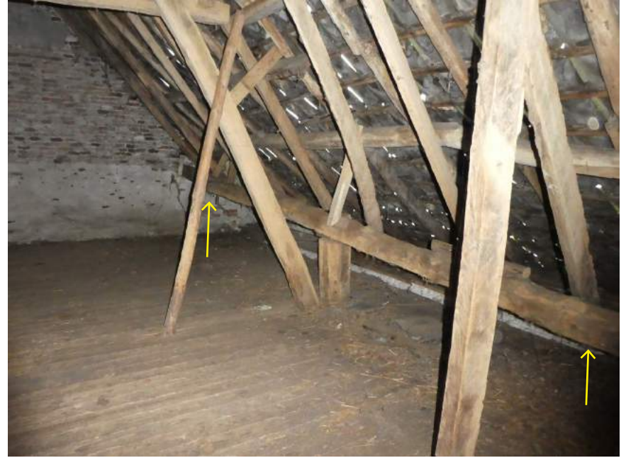
Boven de stal is de gebintplaat het beste zichtbaar. Die loopt in hoogte duidelijk af van woonhuis naar schuur. De plaats van de verwijderde gebintstijlen is met een pijl aangeduid.
