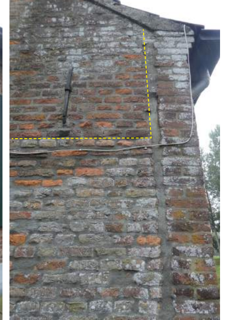
Details van linker zijgevel. Boven de gele stippellijn is de gevel hoger opgemetseld.
