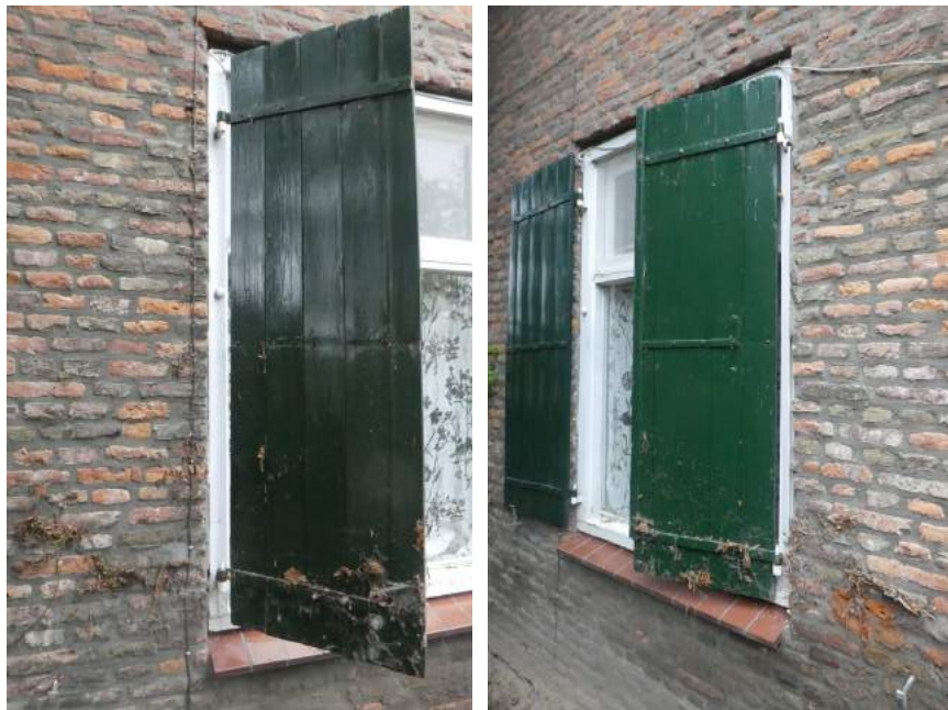
Het metselwerk aan linker en rechter zijde van het venster zijn afwijkend.
