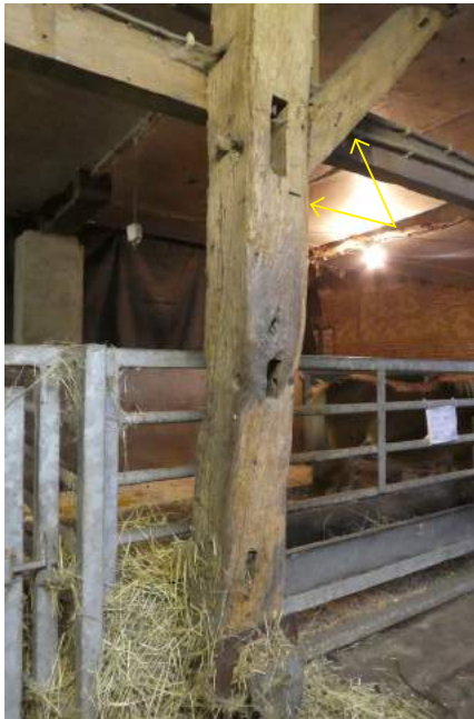
Hergebruikte gebintstijl met telmerk 1 (eerste windschoor). Rechts een standvink, stijl onder de balk met twee korbelen. De stippellijn geeft de las in de balk aan. Daar zijn gebintstijlen aan verbonden.
