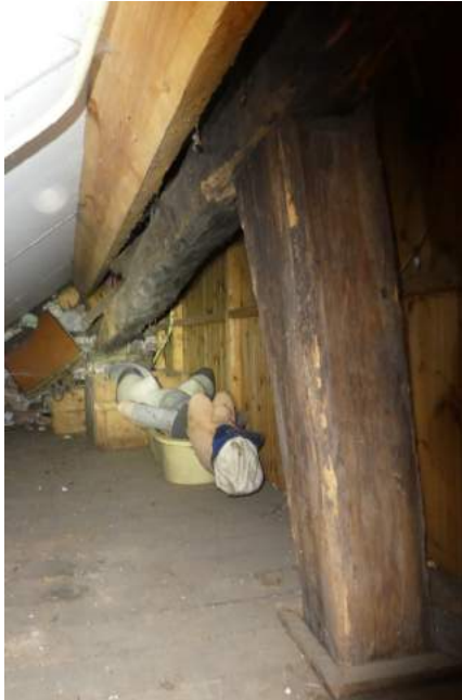
Het oorspronkelijke noordelijke eind van het gebint en de eerste verlenging zijn in de zolderkasten op de verdieping te vinden. De bovenzijde van de gebintstijl op de locatie boven de moerbalk teruggezet.
