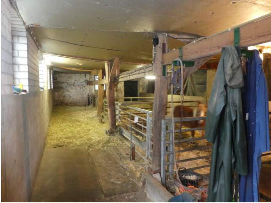
De op de begane grond zichtbare onderdelen van het houtskelet in de voormalige schuur.
