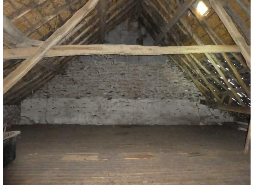
Dakconstructie boven voormalige stal, gezien richting de brandmuur. Links dragen de flieringen nieuwe en hergebruikte daksporen. Rechts is de oude constructie met daksporen gehandhaafd en zijn nieuwe sporen en goringen er overheen geplaatst.
