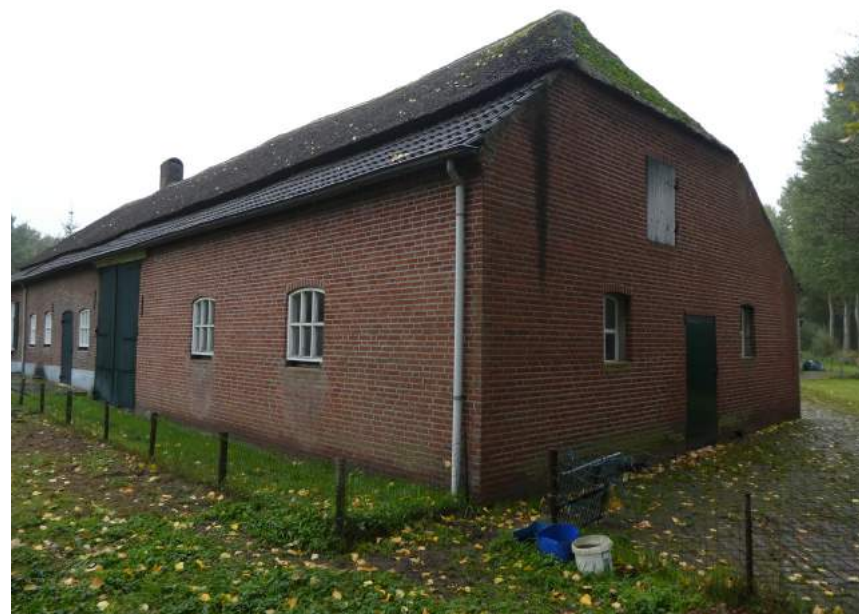
Vernieuwde voor- en zijgevel ter plaatse van de voormalige schuur.
