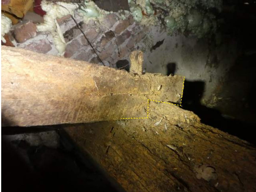
De daksporen van de oorspronkelijke dakconstructie zijn met een hak in een inkeping in de gebintplaat gezet en met een toognagel gezekerd.
