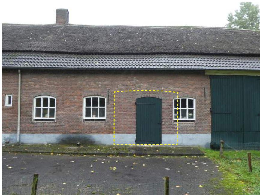
Gevel ter plaatse van de voormalige stal, met een gele stippellijn is de plaats van de voormalige staldeuren aangeduid.
