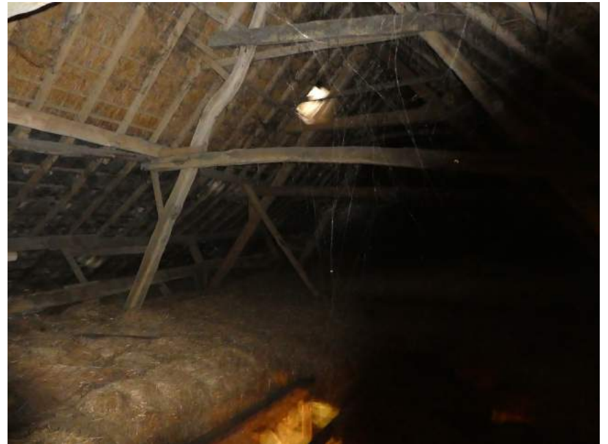
Dakconstructie met spanten en flieringen boven voormalige schuurdeel.
