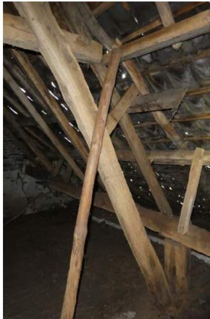
Boven het woonhuis zijn alle daksporen flink beroet. Ook boven de voormalige stal is de oude dakconstructie gehandhaafd.
