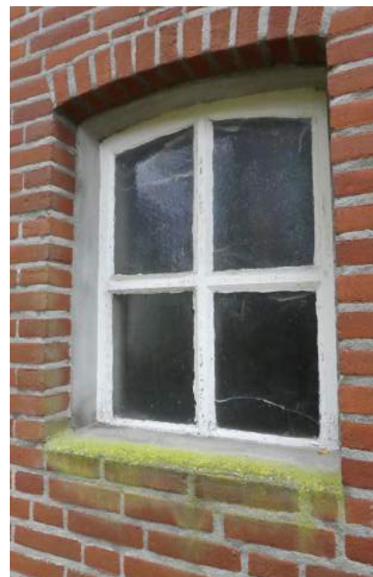
De oude kopgevel en betonraampjes zijn nog achter de voorzetgevel aanwezig.
