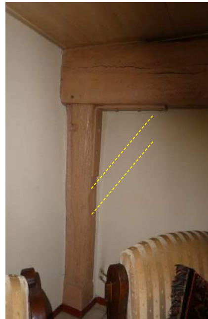
De korbelen zijn door stalen hoeken vervangen.
