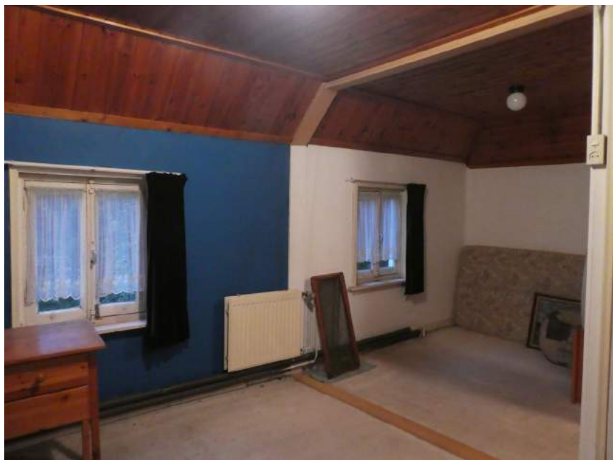
Door de verwijdering van een scheidingswand zijn twee kleine kamers met elkaar verbonden.
