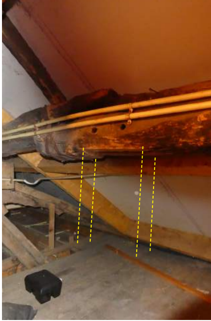
Het oorspronkelijke noordelijke eind van het gebint en de eerste verlenging zijn in de zolderkasten op de verdieping te vinden. De bovenzijde van de gebintstijl op de locatie boven de moerbalk teruggezet.
