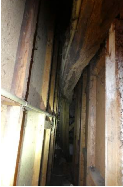
De zelfde dakconstructie is op het woonhuis door voorzetwanden aan het zicht onttrokken.
