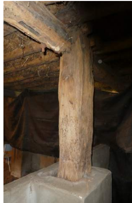
Een hergebruikt bovenstuk van gebintstijl draagt de laatste gebintbalk.
