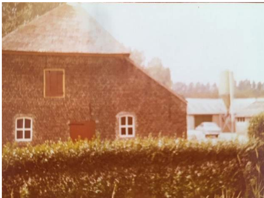
Zicht op de rechter zijkant van de boerderij omstreeks 1970-80. Deze gevel is nu door een recentere gevel verhuisd. Fam. Van Vroenhoven
