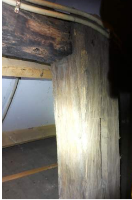
Het oorspronkelijke noordelijke eind van het gebint en de eerste verlenging zijn in de zolderkasten op de verdieping te vinden. De bovenzijde van de gebintstijl op de locatie boven de moerbalk teruggezet.
