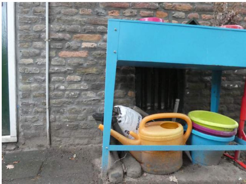
Het keldervenster is voorzien van 'diefijzers'.
