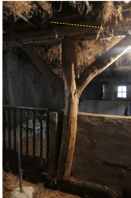
Hergebruikte gebintstijl met telmerk 1 (eerste windschoor). Rechts een standvink, stijl onder de balk met twee korbelen. De stippellijn geeft de las in de balk aan. Daar zijn gebintstijlen aan verbonden.
