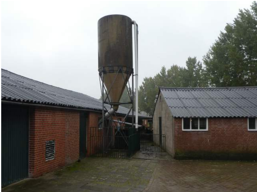
Rechter gevel van bijgebouw 2 met silo en afdak 2b.
