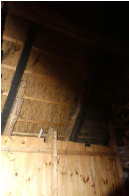
Boven het woonhuis zijn alle daksporen flink beroet. Ook boven de voormalige stal is de oude dakconstructie gehandhaafd.
