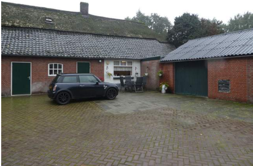
Detail van de achtergevel ter plaatse van de voormalige stal en rechts het woonhuis.
