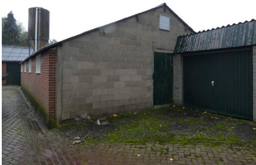
Bijgebouw 1 met aanbouw 1b.
