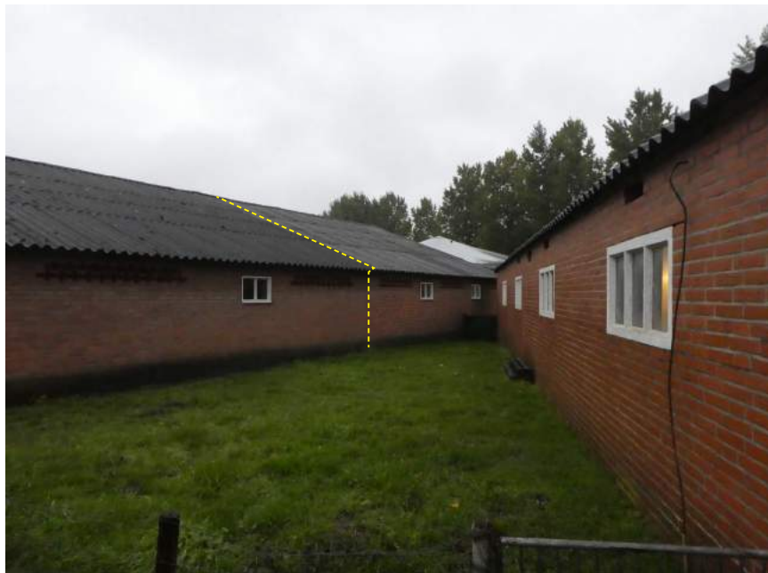
Spievormig grondstuk tussen de stalgebouwen. Op de stippellijn bevindt zich de bouwnaad van de meest recente uitbreiding van bijgebouw 3.
