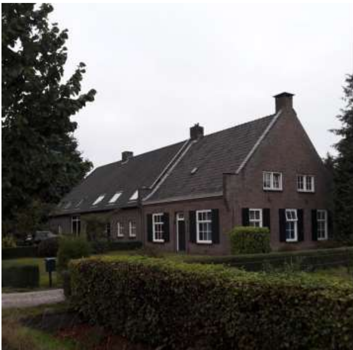
Afb. 31; zuid- en oostgevel.
