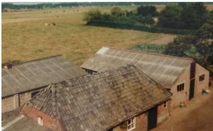
Afb. 49; bakhuis, gezien vanuit het zuidwesten.
