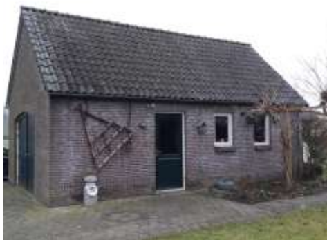
Afb. 27; bijgebouw A.2, oostzijde.
