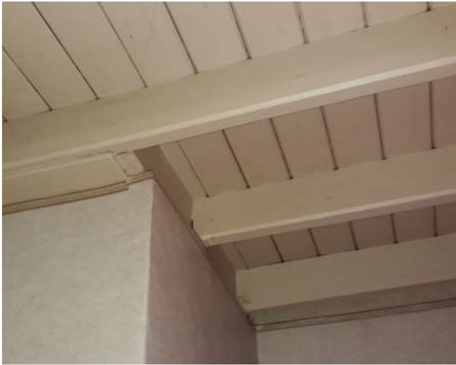
Afb. 44; zoldering op de verdieping. Balkstukken en vellingkanten aan balken en planken.
