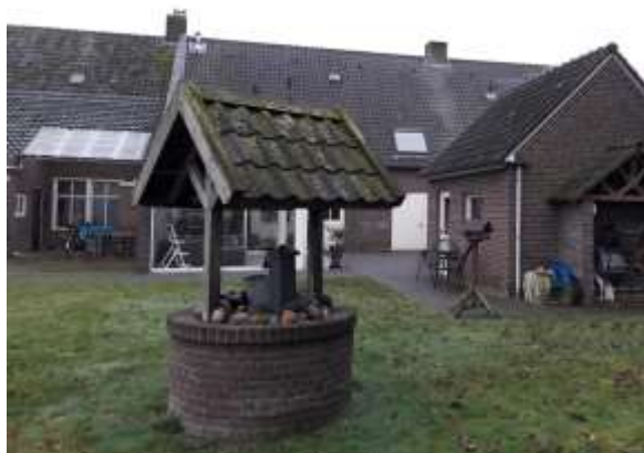
Afb. 29; gebouw B.3 uit het noorden. Voorgrond object B.4.
