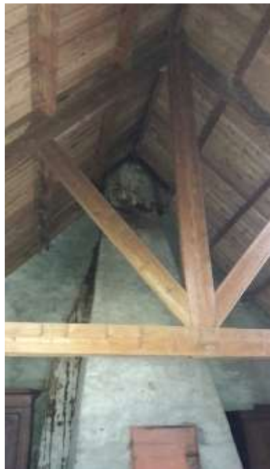
Afb.46; idem tot de nok; rookluik in het schoorsteenkanaal.
