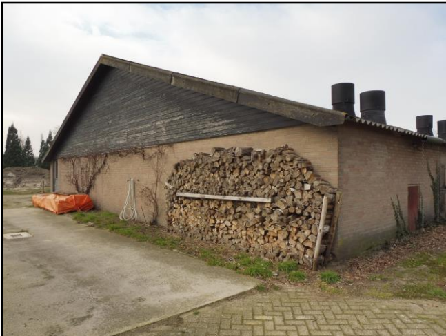
Zicht op de zuidzijde van de varkensstal.
