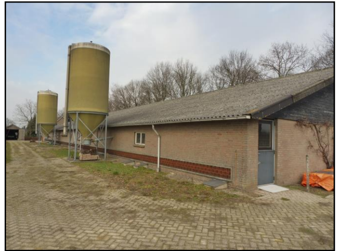
De te slopen varkensstal.
