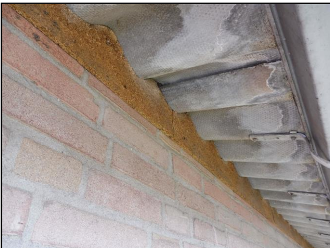
De varkensstal is ontoegankelijk voor vogels en vleermuizen doordat alle spleten, kieren en gaten zijn afgedicht.
