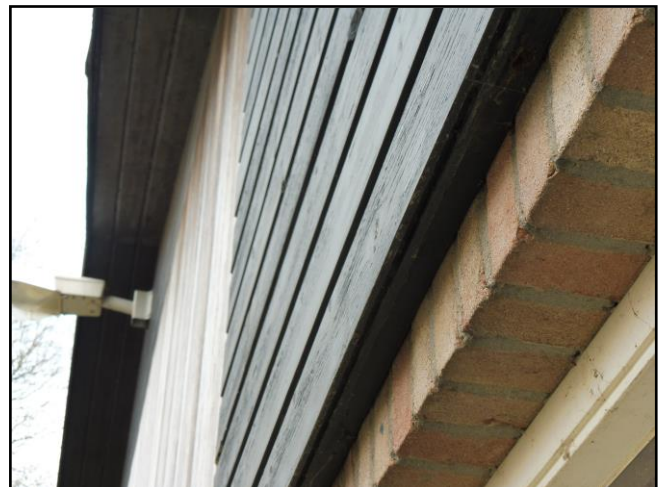
De varkensstal is ontoegankelijk voor vogels en vleermuizen doordat alle spleten, kieren en gaten zijn afgedicht.
