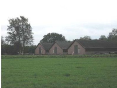
Zicht op stallen vanaf Keldersehoevenweg
