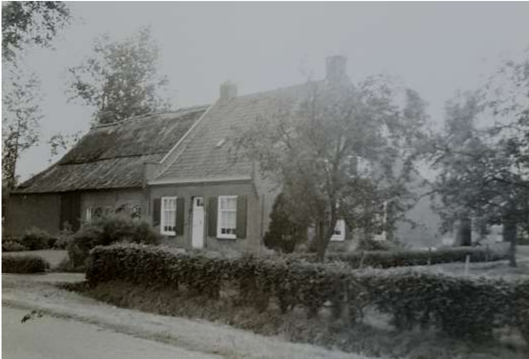
Afb. 19; zuid- en oostgevel. Het bedrijfs gedeelte is nog met stro of riet gedekt (collectie Lanthers-van de Ven).
