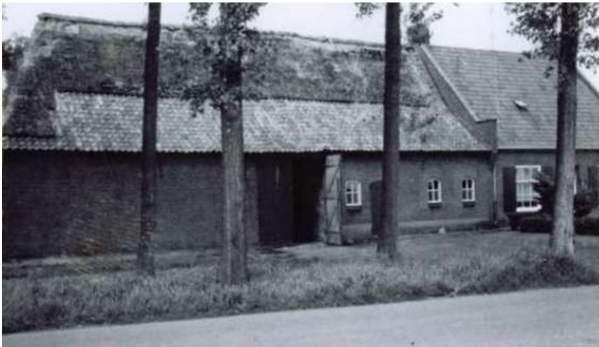
Afb. 17; toestand in 1972. Code 40385; collectie 'Dye van Best'. Het dak heeft een knik bij de overgang van pannen naar stro.
