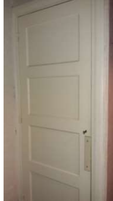
Afb. 41; idem een (nog) onbektele Bruynzeeldeur.
