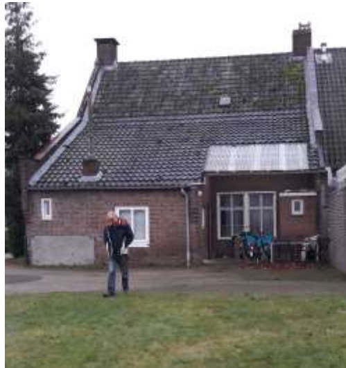
Afb. 35; noordgevel van de woning uit 1941.
