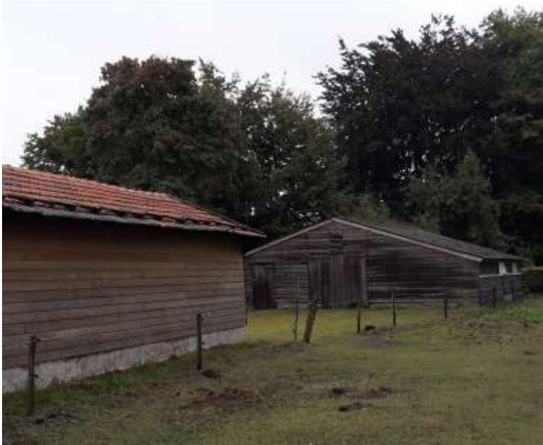
Afb. 51; de bijgebouwen 24.3 en 24.2 vanuit het zuidwesten.
