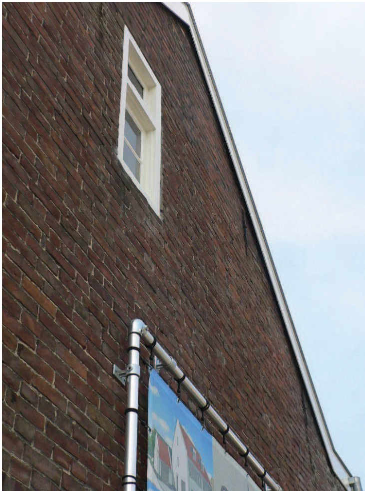
Figuur 3: gevel van naburige pand aan de Nieuwstraat met daklijst.
