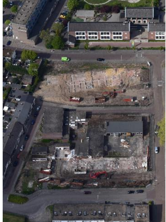
Afbeelding 4: luchtfoto 2017, sloop schoolgebouwen in vergevorderd stadium
