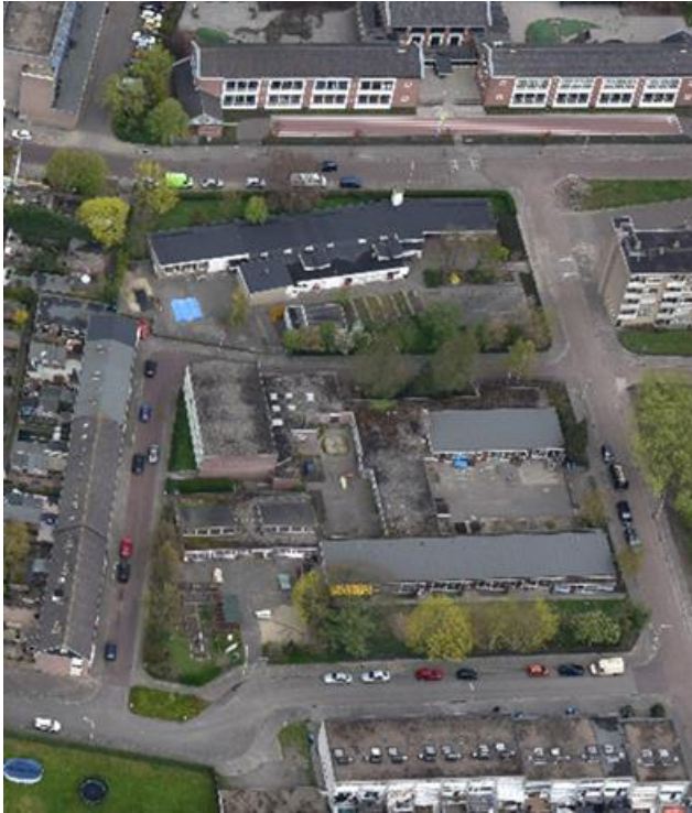
Afbeelding 3: luchtfoto 2016 met schoolgebouwen
