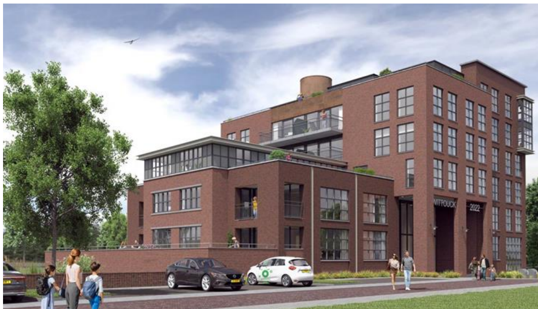
Figuur 2.6: Aanzicht appartementengebouw Wittouck, gezien vanaf de Wittoucksingel (zuidoostzijde)
