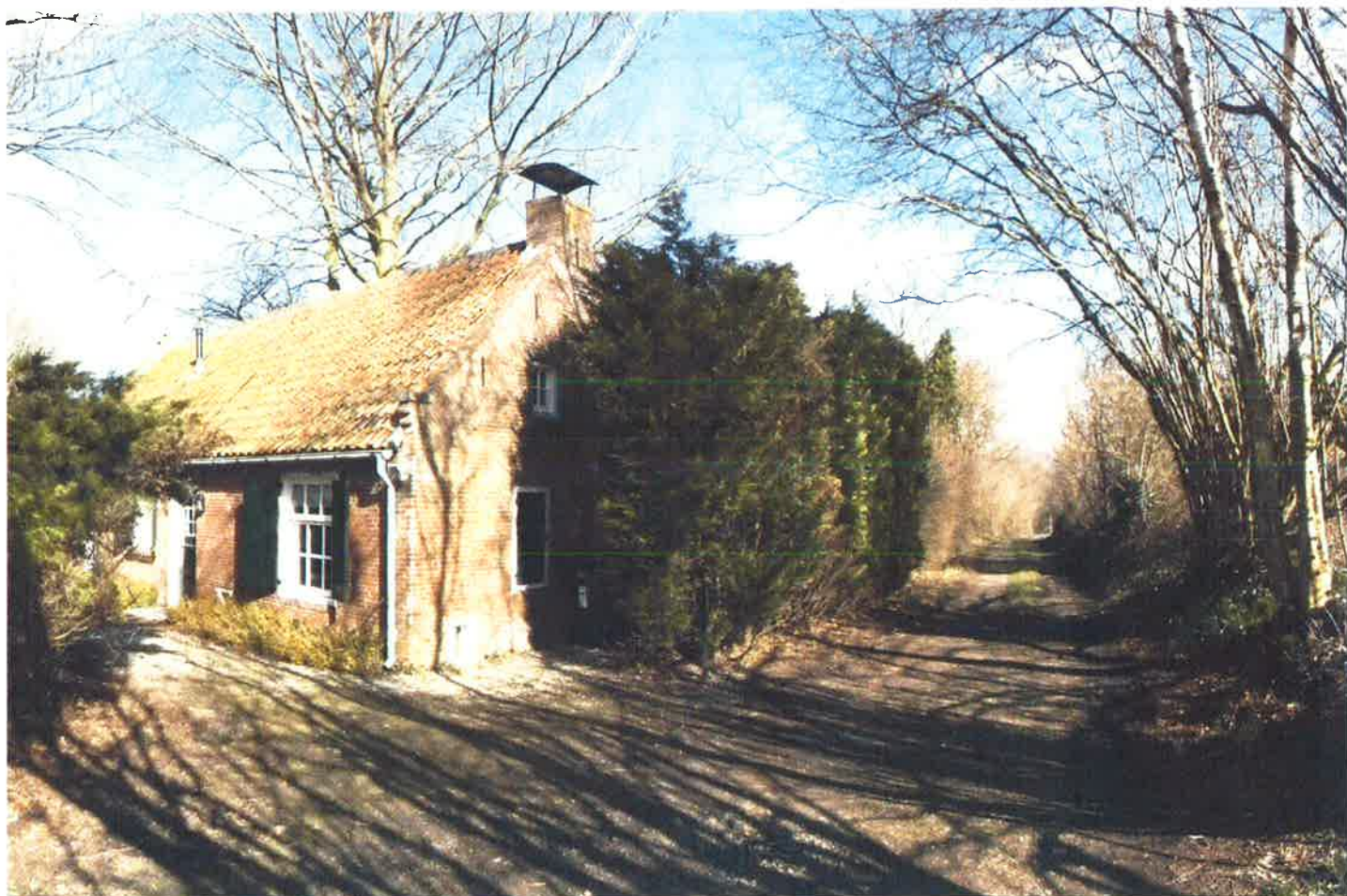
deBOSSA verbouwing woning Fianenstraat 19 te Bergen op Zoom // zienswijze // 24 juni 2014 bijlage 2 foto van de ligging van de woning t.o.v. de toerparadijsweg, gezien vanuit het zuidwesten
