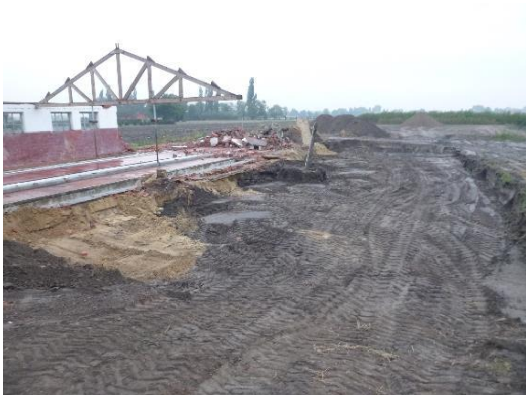
Afbeelding 2. Het plangebied bij start werkzaamheden, blik richting westen (bron: Antea Group).
