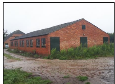
Figuur 5. Westaanzicht van de bebouwing.
