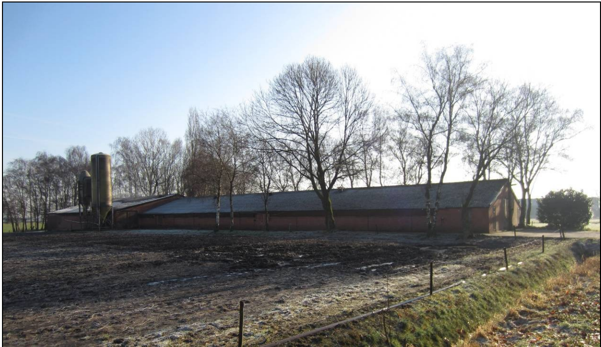
Afbeelding 2.5 Bestaande pluimveestal op gekoppelde locatie
