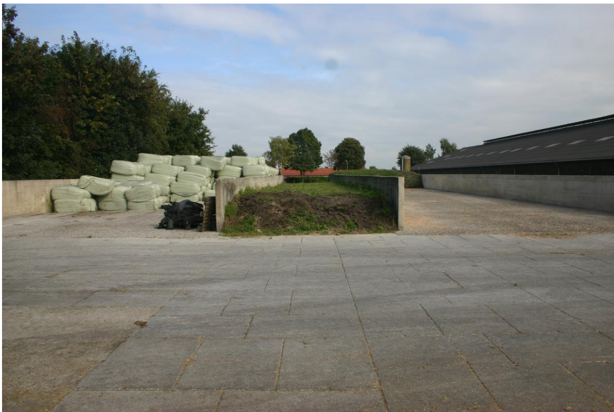
Figuur 2. De te slopen voerkuilen.
