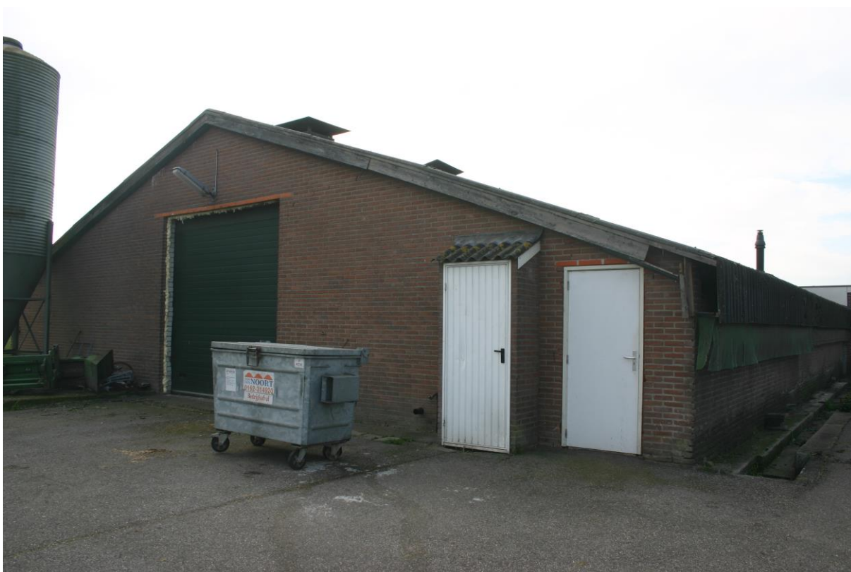
Figuur 3. De te slopen opfokgeitenstal (gebouw C in figuur 1).
