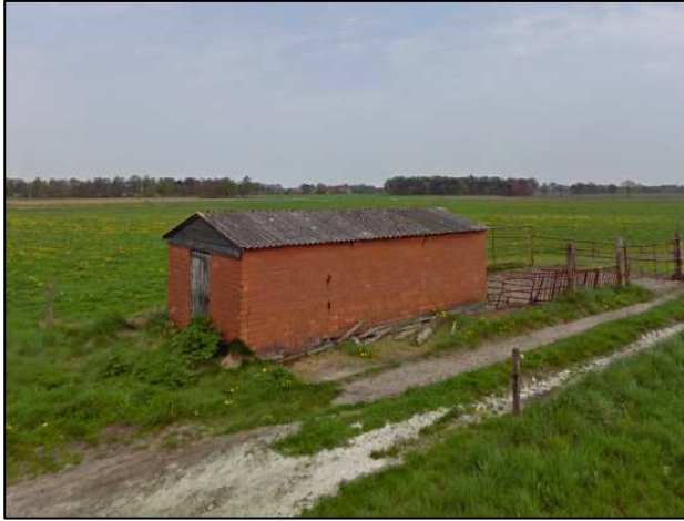
Figuur 25: Foto bestaande schuur gelegen op de locatie Wildertsebaan ong.
