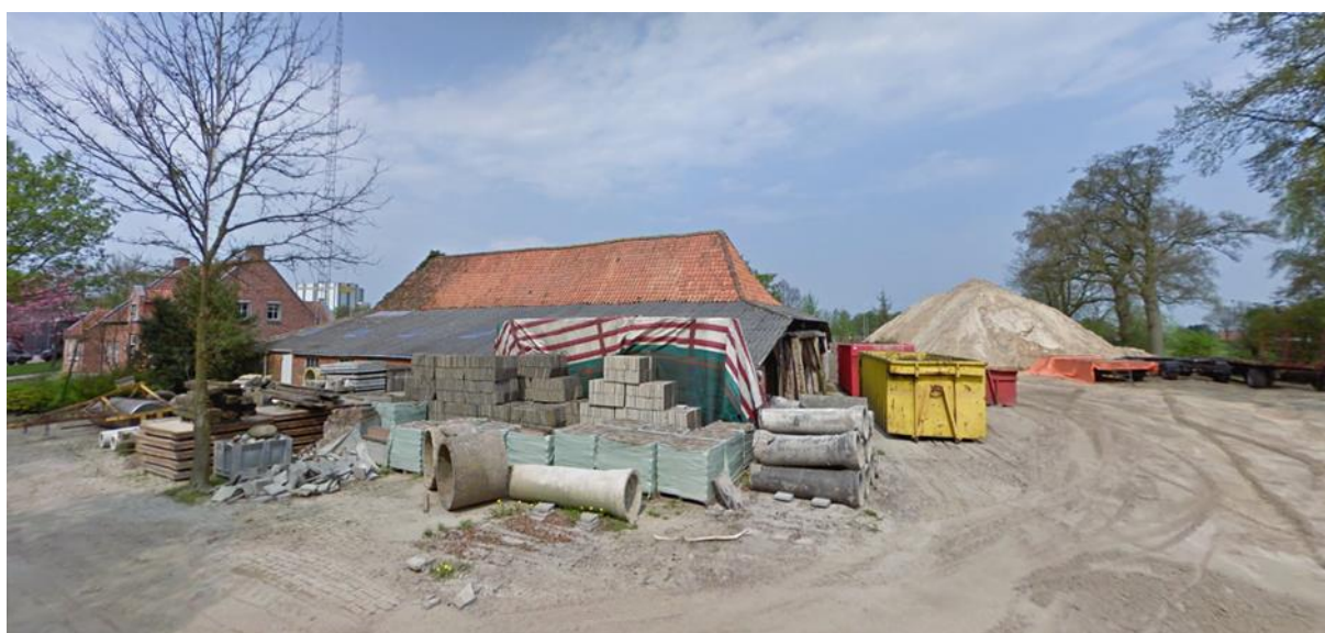
Figuur 12: Aanzicht te slopen loods
