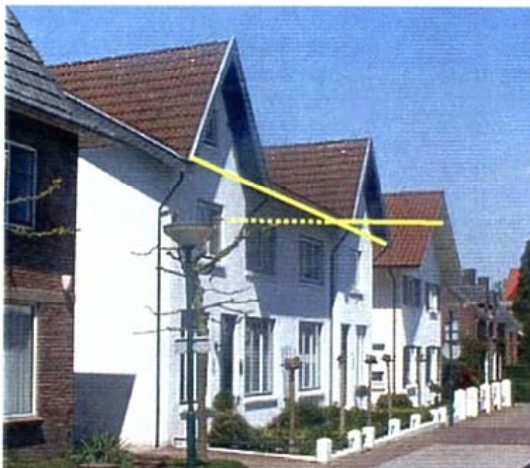
Kniklijn op voor-, achter- en zijgevels
