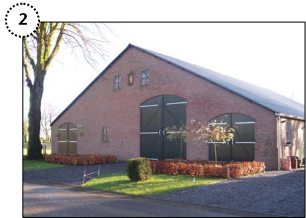
Naoorlogse schuur ten noorden van woonhuis
