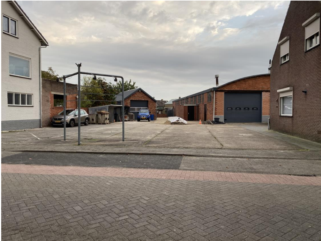
Bestaande situatie plangebied, met de links de bestaande woning Loveren 18 en rechts de bedrijfsloods Loveren 16a
